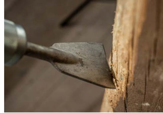
Bild 5: Entfernen der vermulmten Holzbe- reiche mittels Druckluftschälgerät.
