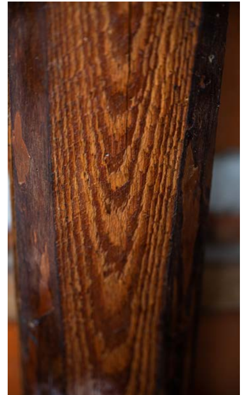
Bild 9: Nach kurzer Zeit ist das Gel ins Holz eingezogen, die Oberfläche des Holzes erscheint nass. Nach der Trocknung ist das Gel farb- und geruchlos, es verbleiben keine Rückstände auf der Holzoberfläche.
