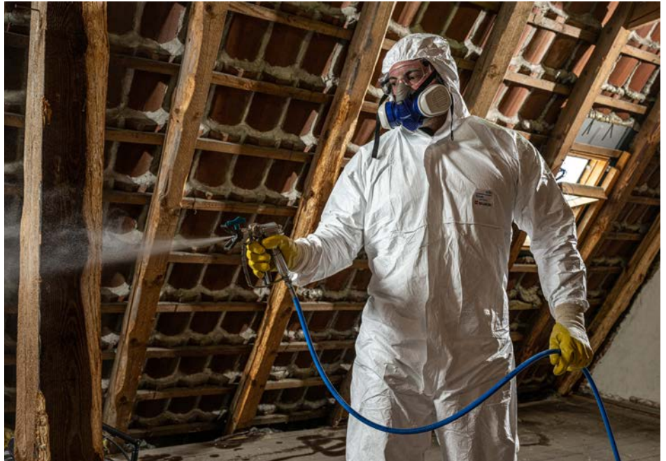
Bild 7: Das gelartige Holzschutz- mittel Xilix Gel® wird mittels Airless- System auf das Holz aufgesprüht.
