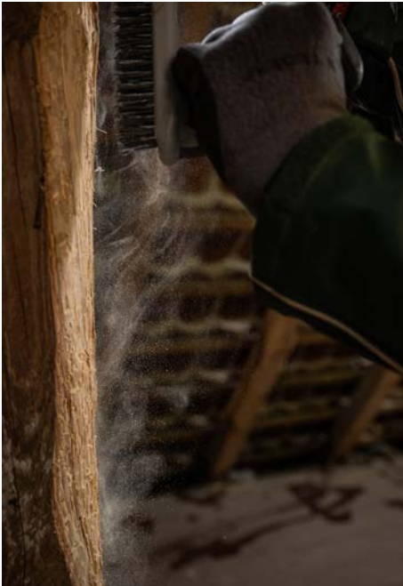
Bild 6: Abbürsten der Holzoberflächen mittels Drahtbürste zum Entfernen des Bohr- mehls.
