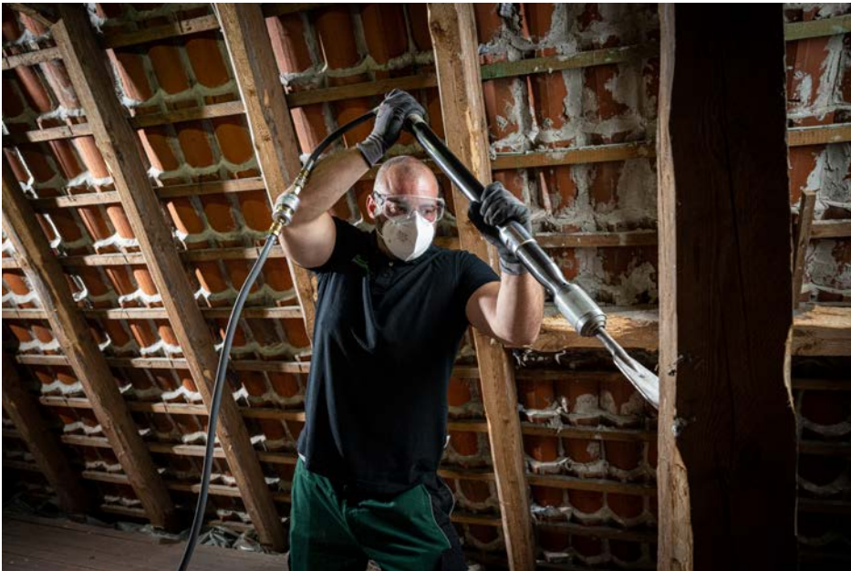
Bild 5: Entfernen der vermulmten Holzbe- reiche mittels Druckluftschälgerät.
