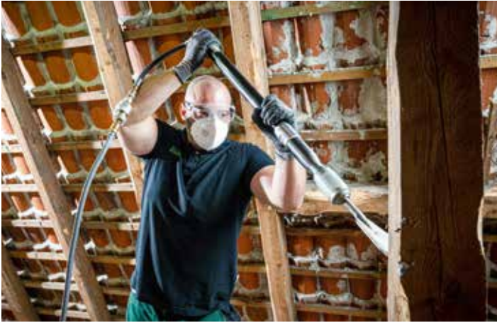
Entfernen der vermulmten Holzbereiche mittels Druckluftschälgerät.
