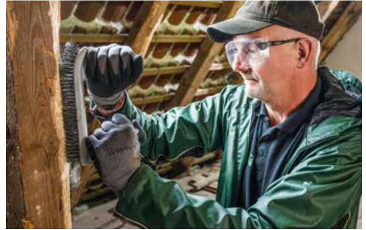
Abbürsten des Holzes mittels Drahtbürste zum Entfernen des Bohrmehls.
