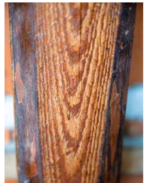
Nach kurzer Zeit ist das Gel ins Holz eingezogen, die Oberfläche des Holzes erscheint nass. Nach der Trocknung ist das Gel farb- und geruchlos.
